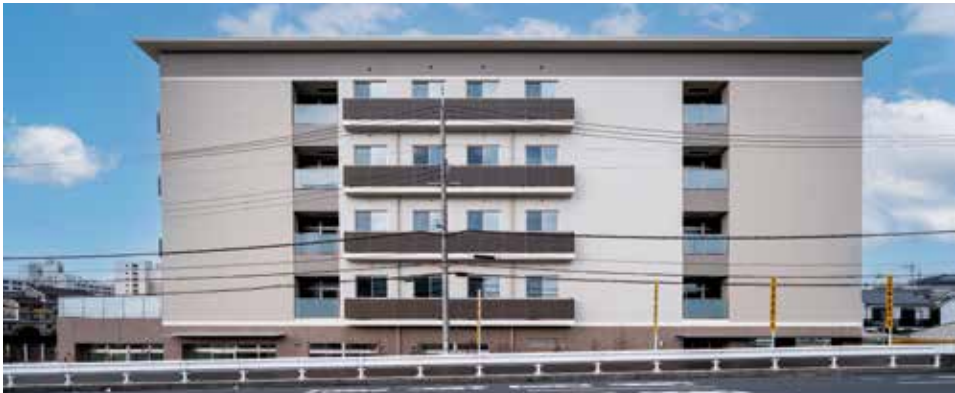
十条通の対側から見る南面ファサード 水平ラインを整え、ボリューム感の軽減を図る
