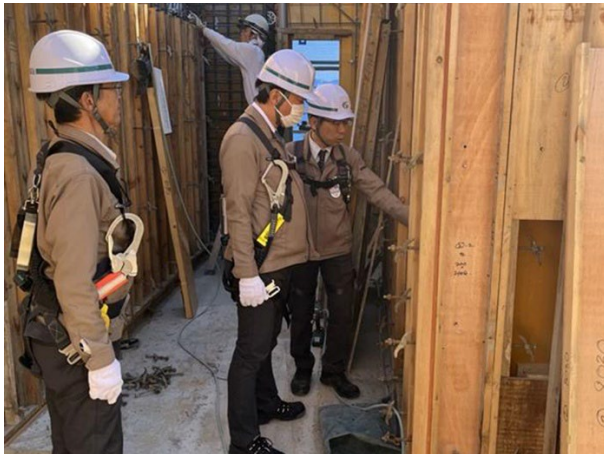
建込階の通路確認をする高松社長（中央）
